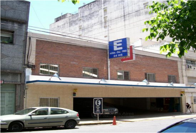
FACHADA Barrio: RECOLETA · Edificación alta (PB + 7 + 2 Retiros).
